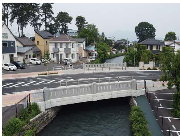
架け替え後の石川橋（広瀬川下流より）
