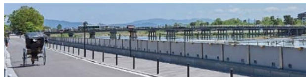
可動式止水壁（起立時）
