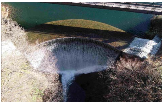
補強工事の完成
