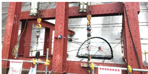
無振動大ブロック分割引出工法
