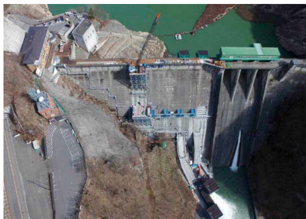
堤体削孔施工状況全景
