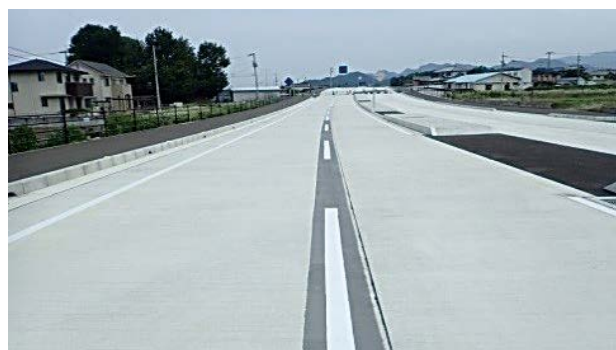
背景線の施工状況
