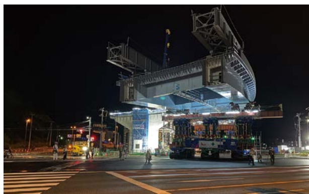
多軸式特殊台車による桁運搬状況
