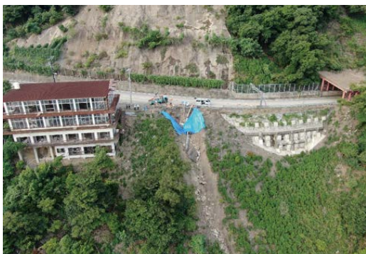
国道8号の被災状況
