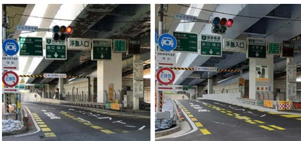
浮島入口（左：施工前、右：施工後）
