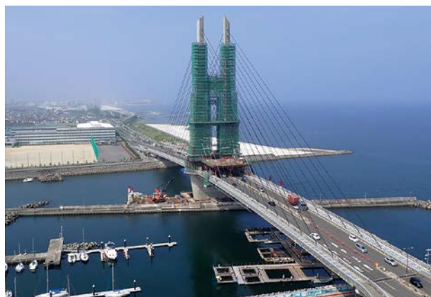
耐震補強 工事状況写真
