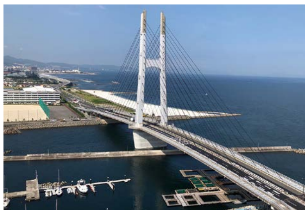
耐震補強 完成写真
