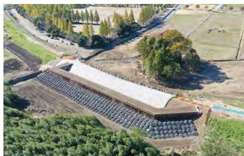
都幾川右岸0.4K (埼玉県東松山市早俣地先)
