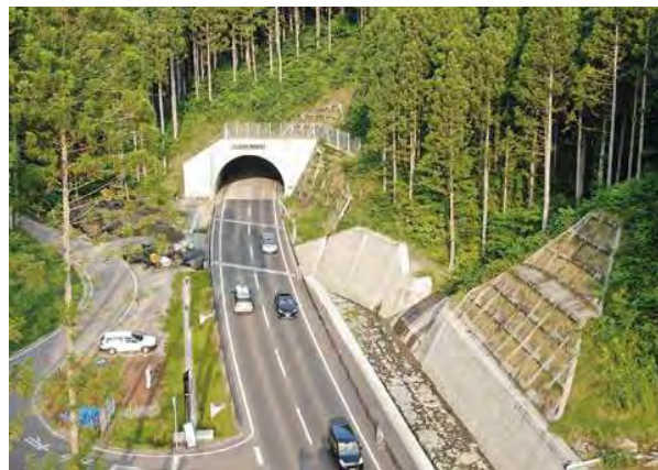
完成写真（村田町側から望む）
