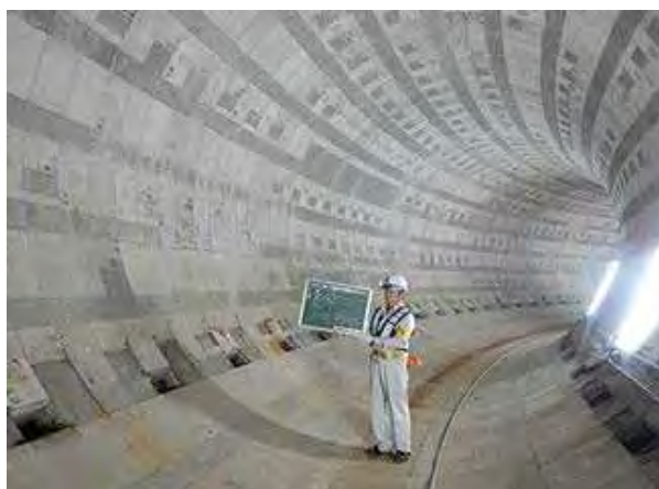
急曲線部（R=30m）の施工状況
