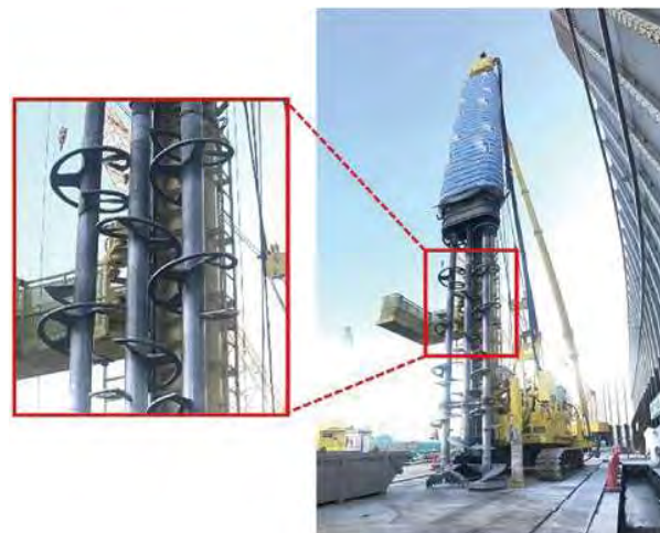
孔あけ型特殊攪拌スクリー 取付状況
