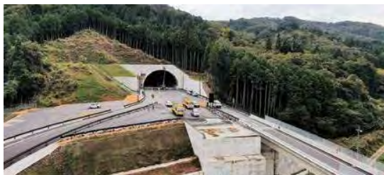
上佐野トンネル 北側坑口
