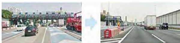
撤去前 撤去後 大井本線料金所の撤去前撤去後
