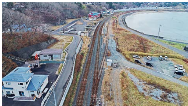
嵩上げ整備・防潮堤整備された八木地区
