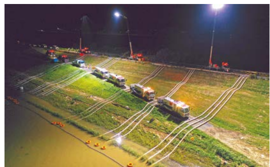
【宮城県大崎市】排水ポンプ車による24時間体制での緊急排水
