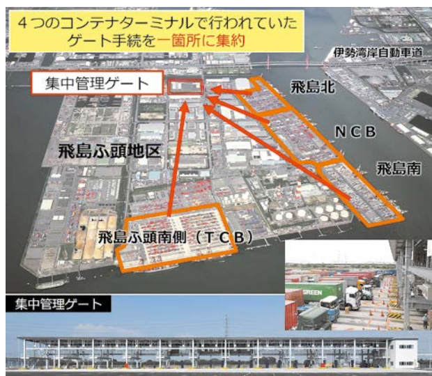
飛島ふ頭地区のコンテナターミナルと集中管理ゲート
