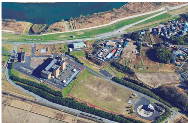
首都圏外郭放水路 庄和排水機場
