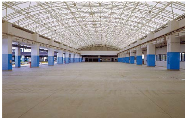
原釜荷捌施設セリ場（膜屋根）
