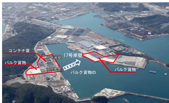
17号岸壁の完成
