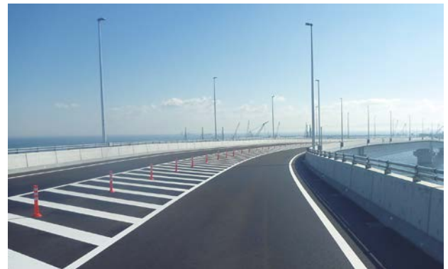
完成後 海上橋梁部付近
