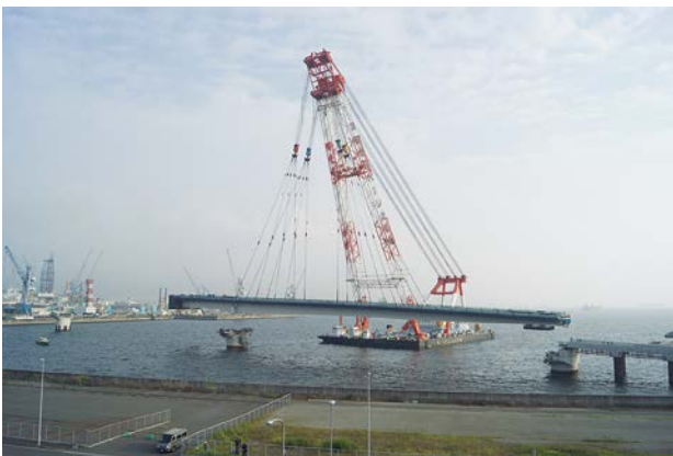
フローティングクレーンによる桁架設状況
