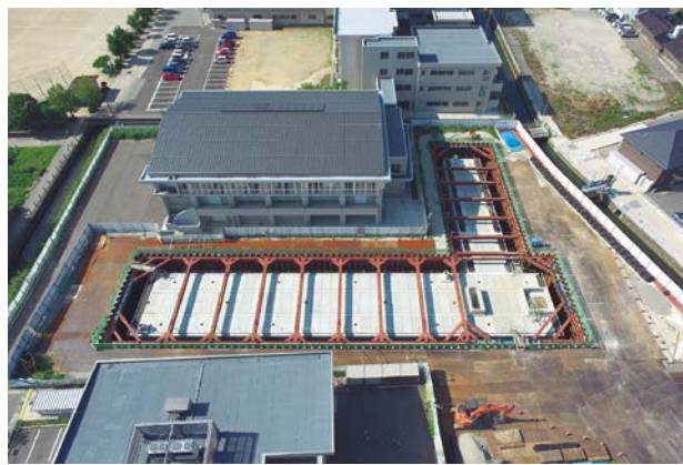
プレキャストブロック据付完了
