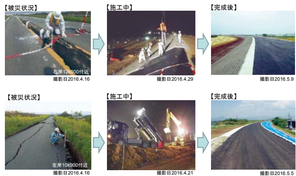
緊急復旧の施工状況
