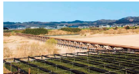
復旧した上津屋橋
