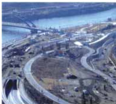
新たな防災拠点の完成
