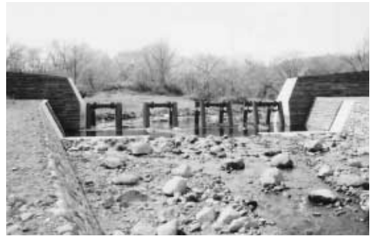
苦戸川透過式鋼製堰堤工
