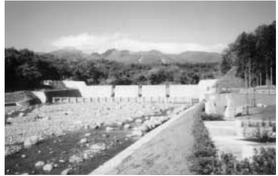
余笹川2号砂防堰堤工・流木止補足工
