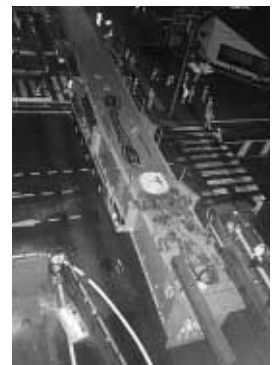
高速埼玉新都心線新都心西出入口工事
