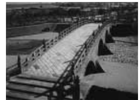
移設復元された西田橋
